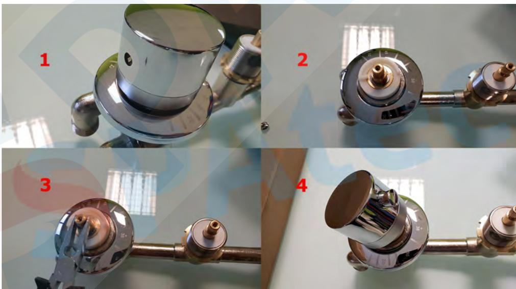
1. Retirer le bouchon plastique bleu et rouge du capuchon du robinet d'eau chaude/froide.
